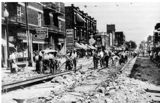
Enlèvement des rails, rue Bélanger près de Saint-Denis, en 1950
