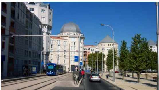
Avenue Moulares : le nouveau projet urbain et le Nouveau Tramway réalisés simultanément
