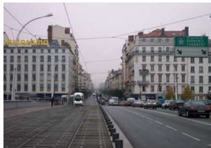
Lyon, Pont Gallieni
